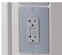
Juego de enchufe eléctrico doble 9851500, 115 V, 20 A de CA, GFCI, 60 Hz
